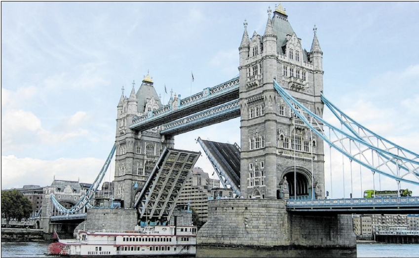
▲ Die Brückenhälften der Tower Bridge heben sich für die Schiffe. Die sogenannten Baskülen wiegen jeweils 1045 Tonnen – sie sind damit fast so schwer wie 300 Autos.
