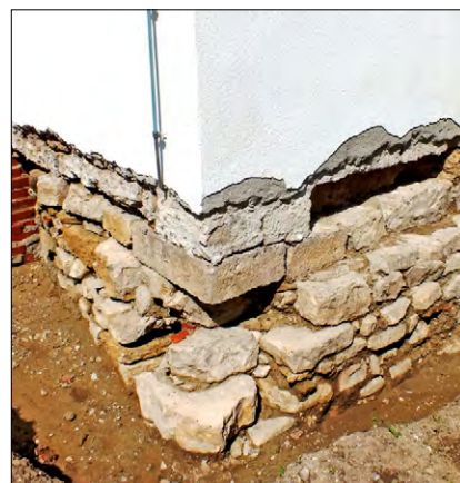
▲ Saniert werden mussten nach eingehender Prüfung auch die Fundamente.
