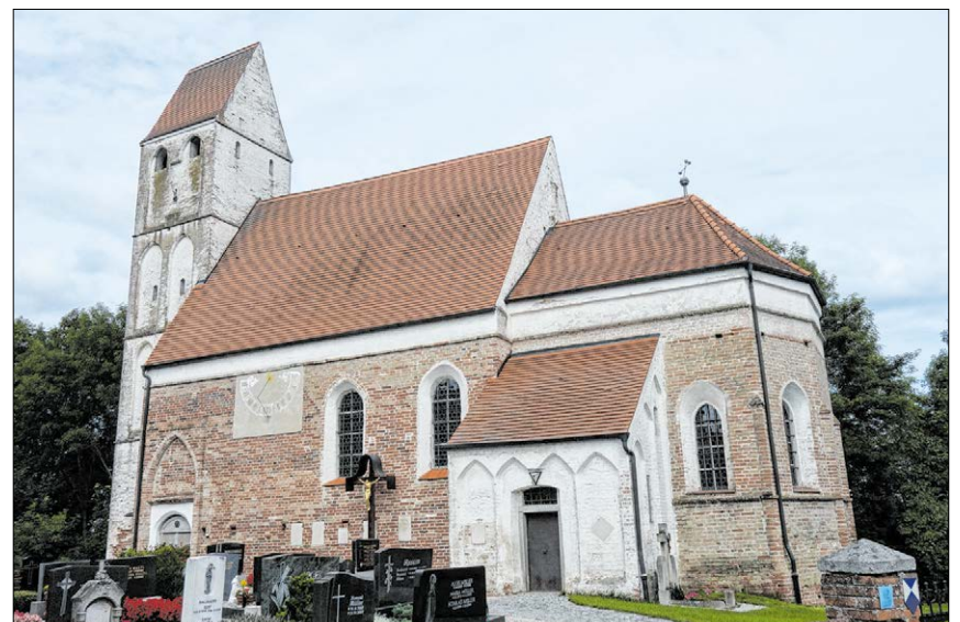
▲ Außenansicht des spätgotischen Backsteinbaus.
