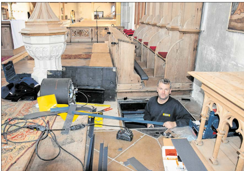
▲ Mit der Erneuerung der Heizungsanlage in St. Johannes Baptist ist hier Alen Feriz hinter dem Altar beschäftigt. Foto: Verspohl-Nitsche
