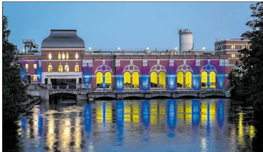
▲ Nachdem 1898 mit dem Bau des Lechkanals begonnen worden war, ging 1901 das Wasserkraftwerk in Gersthofen in Betrieb. Es ist damit eines der ersten großen Wasserkraftwerke in Bayern. Das Kraftwerksgebäude, das mit großen Rundbogenfenstern und Sichtmauerwerk im Stil des Historismus errichtet wurde, ist überwiegend im Originalzustand erhalten. Fotos: LEW (3)
