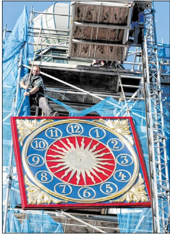
▲ Montage einer Turmuhr. Foto: Turmuhr Rauscher
