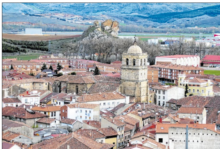
◀ Blick vom Burghügel auf das Städtchen Aguilar de Campoo. Die Kirche ist nur scheinbar eingezwängt zwischen den Häusern.
